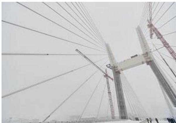
Осенью прошлого года ванты и пролетные строения проверили на прочность – по мосту проехали 12 грузовиков с песком. Результаты испытаний показали, что мостовой переход отвечает всем техническим требованиям и готов к пропуску, в том числе, большегрузов общим весом до 100 тонн (<https://ngs.ru/text/transport/2025/01/02/74921309/>).
