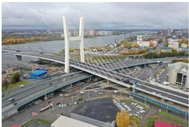
В конце сентября по Четвертому мосту проехали 12 грузовиков для проверки устойчивости конструкции.
