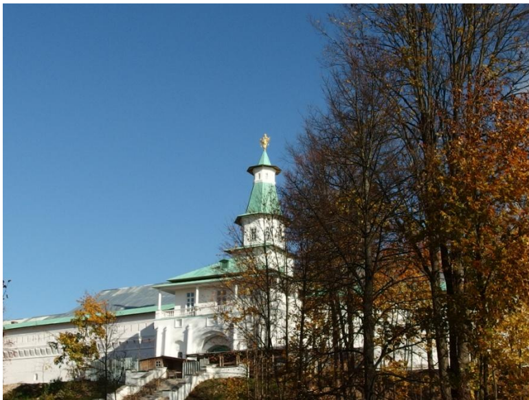
Второй вход в монастырь еще не отремонтирован
